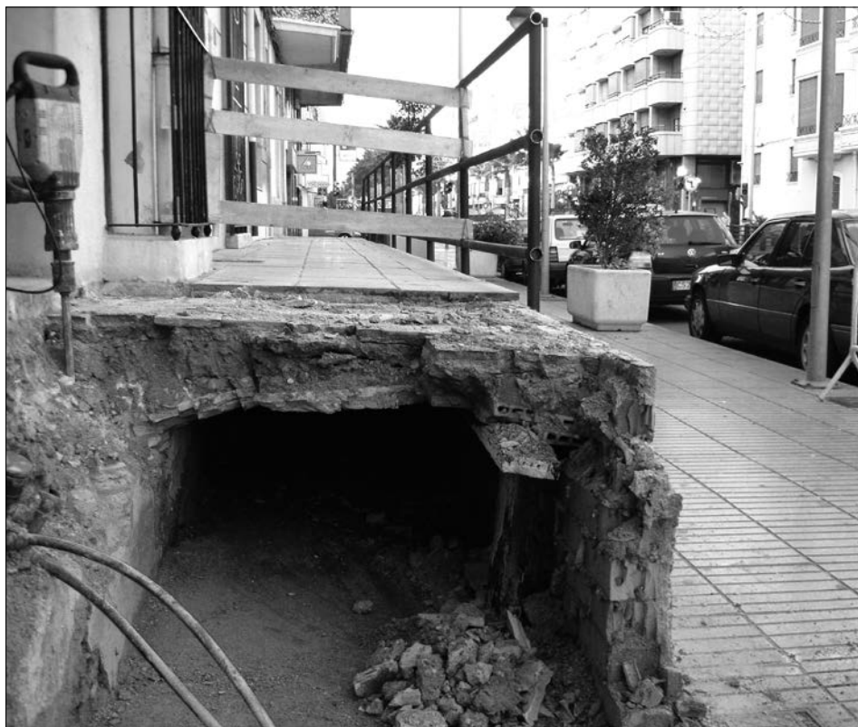
La Sequiola, descoberta durant unes obres a l'avinguda de la Murà (foto de l'Arxiu de la Comunitat de Regants)
