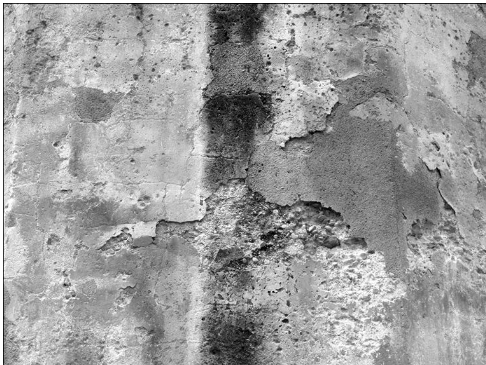
Danys en el revestiment original
