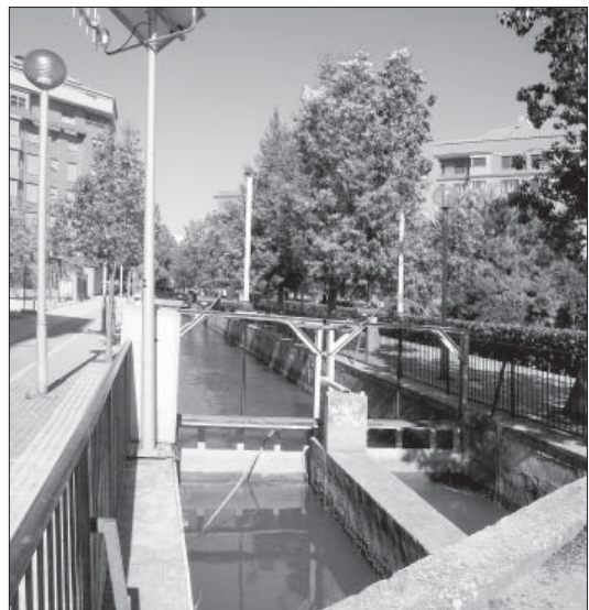
Comporta al carrer de les Solades
