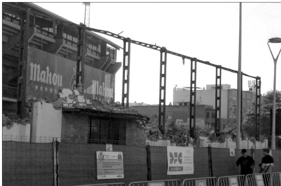
Enderrocament del pavelló del Campió Llorens
