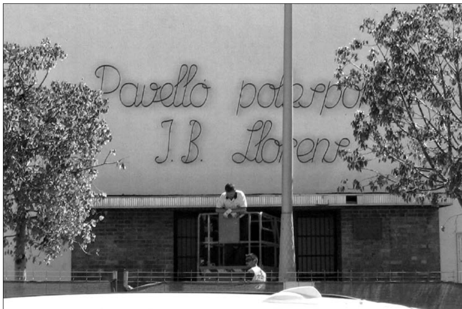
Enderrocament del pavelló del Campió Llorens
