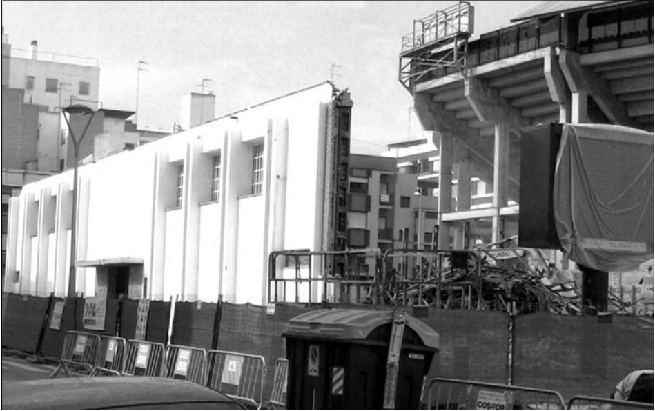
Enderrocament del pavelló del Campió Llorens
