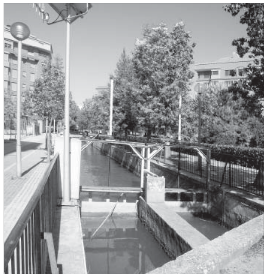
Comporta al carrer de les Solades
