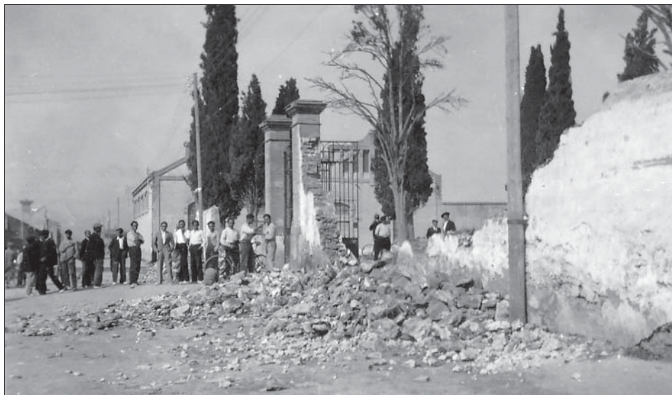
Calvari, enderrocament del mur, 1 de maig de 1931
